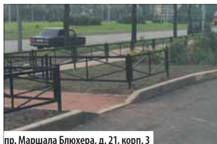
пр. Маршала Блюхера, д. 21, корп. 3
