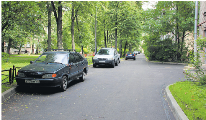
ул. Васенко, д. 6/10. Замена асфальтового покрытия
